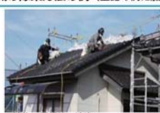
●建物の屋根等の洗浄
