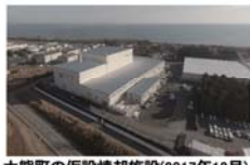
大熊町の仮設焼却施設(2017年12月)
