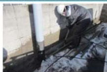
●側溝の汚泥の除去 (提供) 福島市
