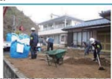
●庭土等の土壌の削り取り (提供) 伊達市
