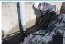
●側溝の汚泥の除去 (提供) 福島市
