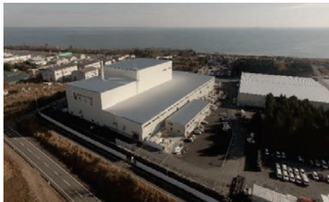
大熊町の仮設焼却施設(2017年12月)
