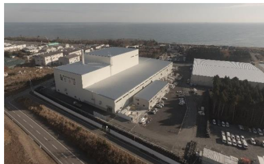
大熊町の仮設焼却施設(2017年12月)
