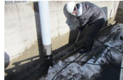
●側溝の汚泥の除去 (提供) 福島市
