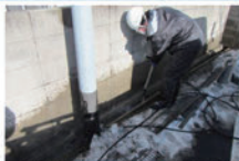
●側溝の汚泥の除去 (提供) 福島市
