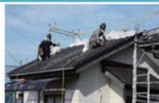
●建物の屋根等の洗浄
