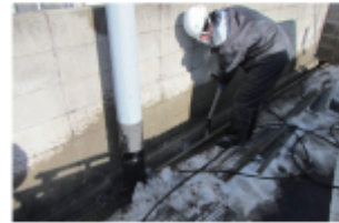
●側溝の汚泥の除去 (提供) 福島市
