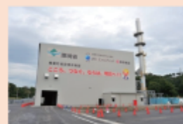
楡葉町の仮設焼却施設（2016年10月）
