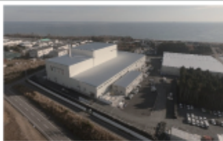
大熊町の仮設焼却施設(2017年12月)
