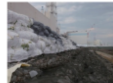
仮設防潮堤(出典：東京電力HPより)
