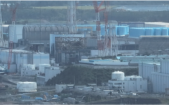
地震後の東京電力福島第一原子力発電所
