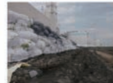
仮設防潮堤(出典：東京電力HPより)
