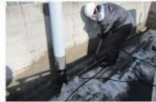
●側溝の汚泥の除去 (提供) 福島市
