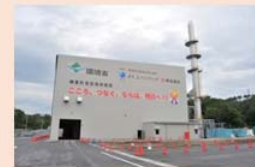
楢葉町の仮設焼却施設(平成28年10月)
