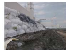
仮設防潮堤(出典：東京電力H Pより)
