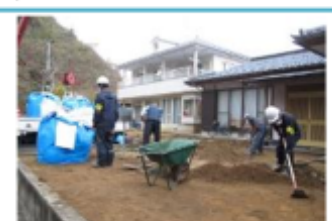
●庭土等の土壌の削り取り (提供) 伊達市
