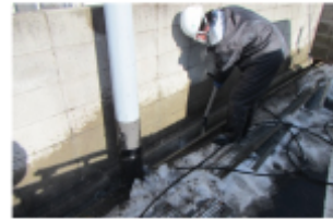
●側溝の汚泥の除去 (提供) 福島市
