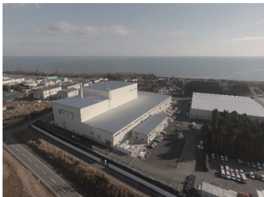
大熊町の仮設焼却施設(平成29年12月)
