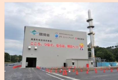
楢葉町の仮設焼却施設 (平成28年10月)
