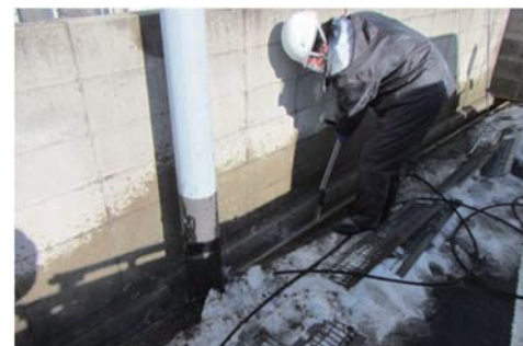
●側溝の汚泥の除去
