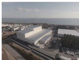
大熊町の仮設焼却施設(平成29年12月)
