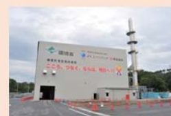
楡葉町の仮設焼却施設(平成28年10月)
