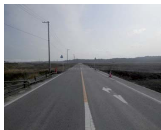
撤去後（平成28年3月）
