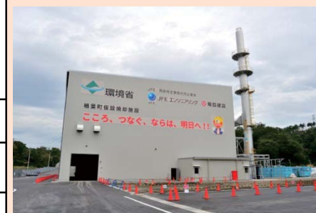
楢葉町の仮設焼却施設（平成28年10月）
