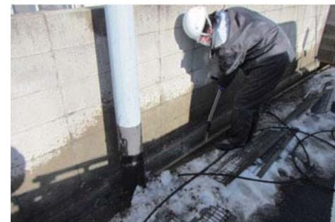
●側溝の汚泥の除去 (提供)福島市
