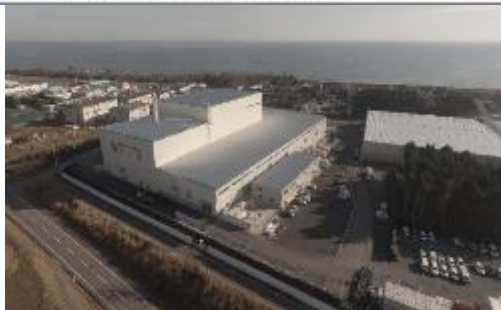
大熊町の仮設焼却施設(2017年12月)
