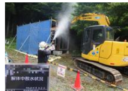
被災家屋等の解体の様子
