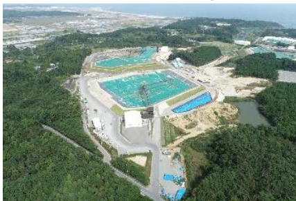
土壌貯蔵施設(双葉①工区)
