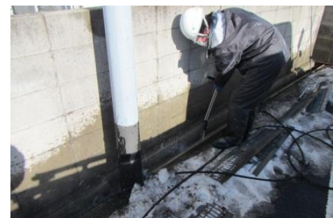
●側溝の汚泥の除去 (提供) 福島市
