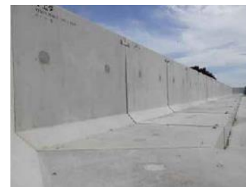
防潮堤(出典：東京電力HPより)
