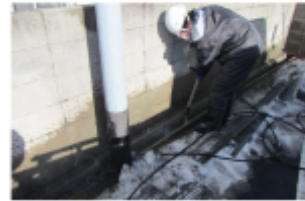
●側溝の汚泥の除去 (提供) 福島市
