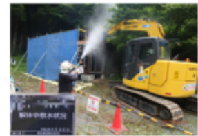
被災家屋等の解体の様子 環境省作成
