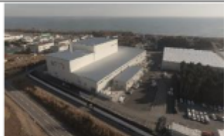
大熊町の仮設焼却施設(2017年12月)
