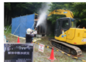
被災家屋等の解体の様子
