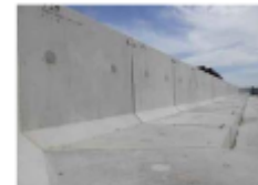
防潮堤(出典：東京電力H Pより)
