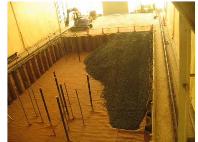
写真 3.3.4 碎石層敷設状況
