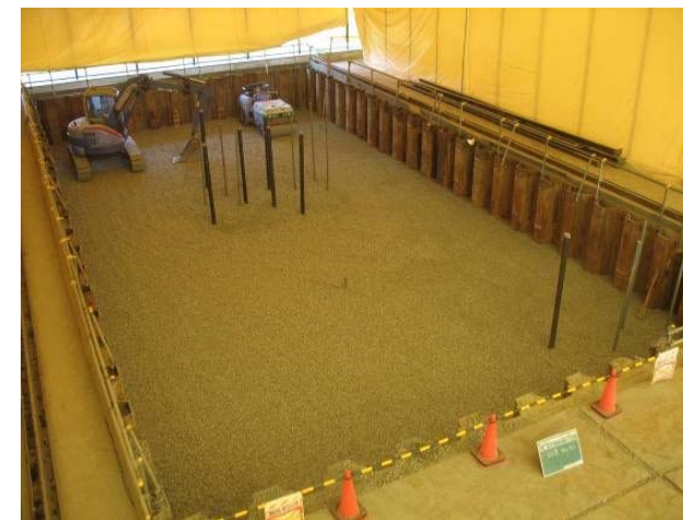
写真 3.3.5 碎石層敷設完了状況
