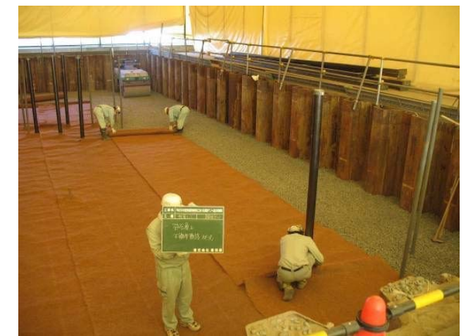
写真 3.3.6 碎石層上面不織布敷設状況
