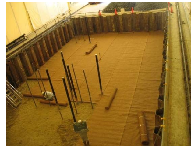
写真 3.3.3 碎石層下面不織布敷設状況（下面）
