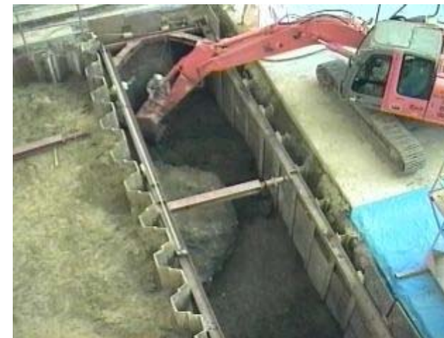
2005年7月11日 西端外側部の掘削
