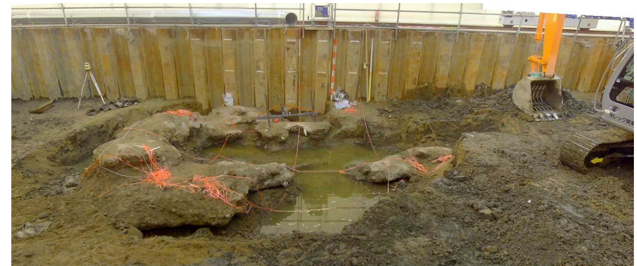
図 1.2.9 汚染源掘削調査により発見されたコンクリート様の塊（2005 年 1 月 27 日）
