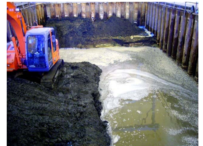
2005年4月6日（塊下部をGL-4mまで掘削）
