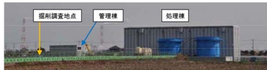
図 1.1.1 高濃度汚染対策施設全景
