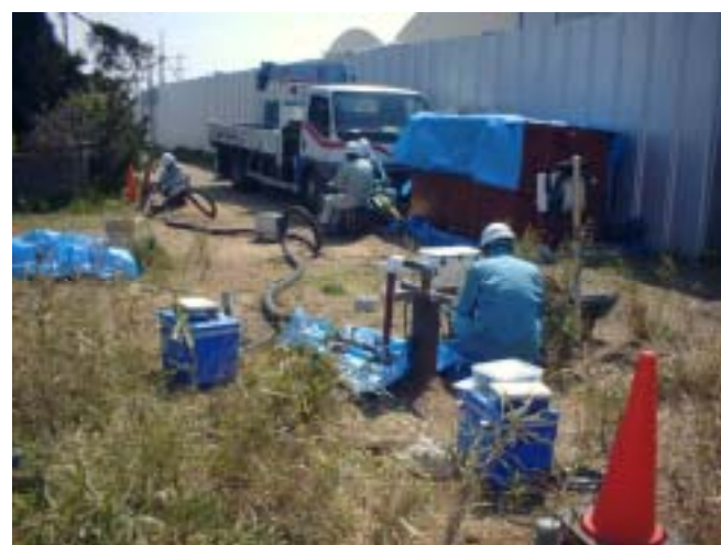
写真2.4.1 揚水試験全景
