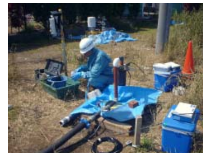
写真2.4.2 揚水試験 A井戸直近 30m
