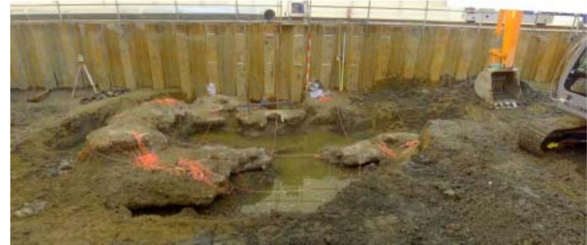
図 0.1.1 汚染源掘削調査により発見されたコンクリート様の塊（平成 17 年 1 月 27 日）
