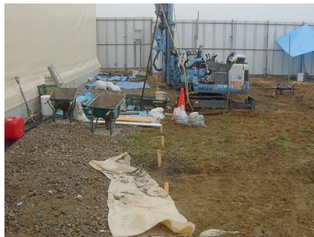
南北方向を南側より見る
