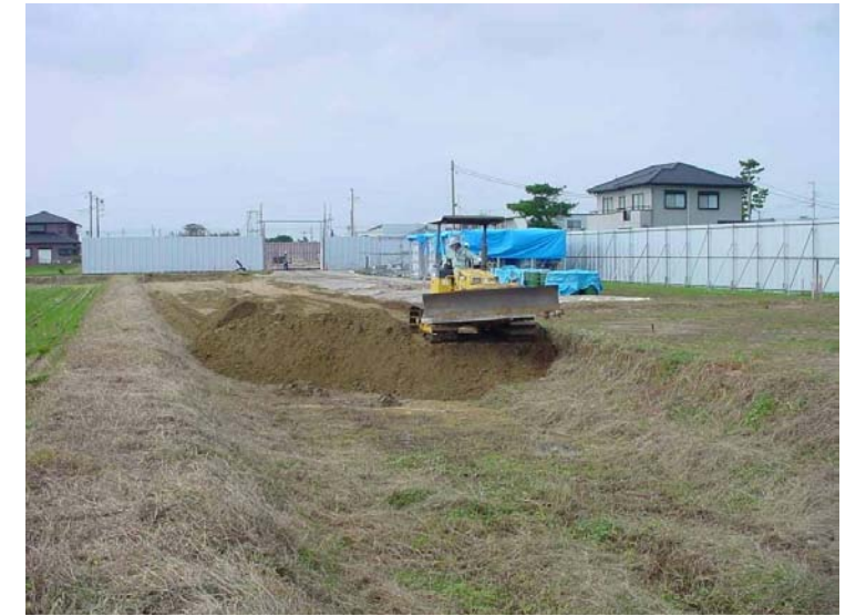
H16.10.14 敷地南側造成中
