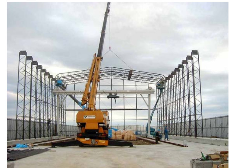
H16.11.29 仮設テント組立て中
