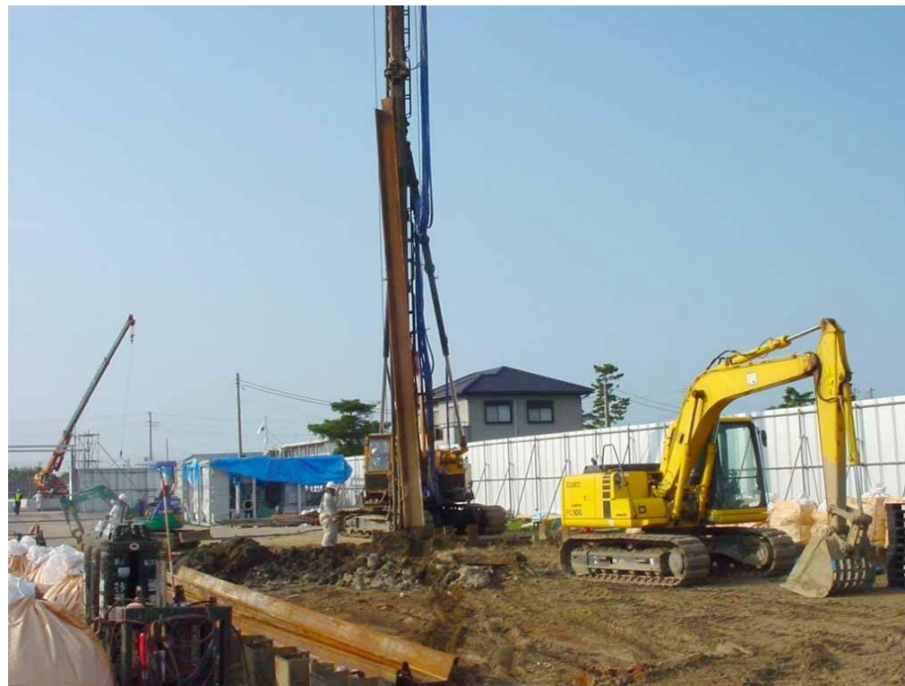
H16.11.8 土留め矢板打設中
