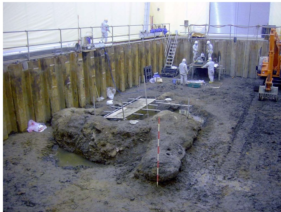
H15.2.3 西側塊のコア抜き作業 (深さ 2.5m まで掘削済み)
