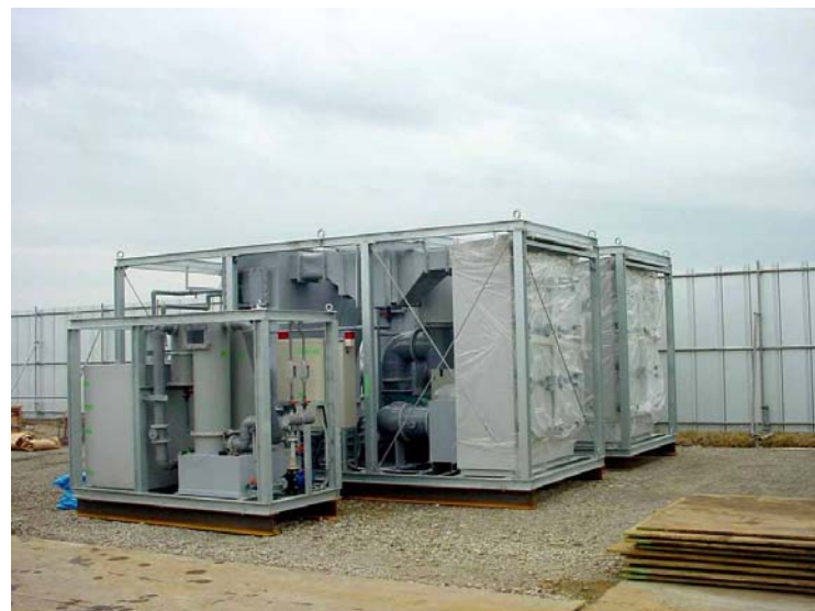
排気除染装置
