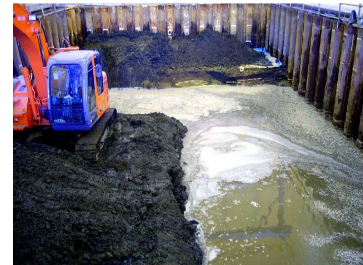
H17.4.6 塊下部を GL-4m まで掘削
