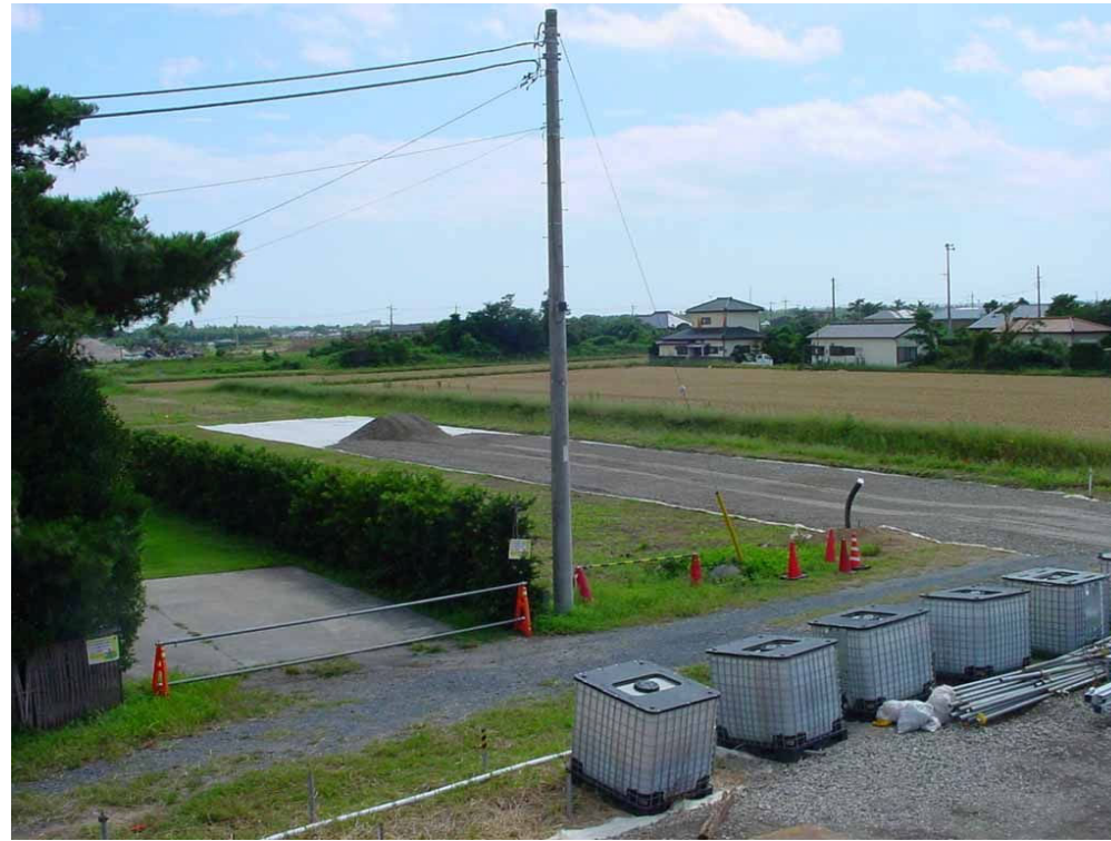
H16.9.21 仮設進入路整備中
