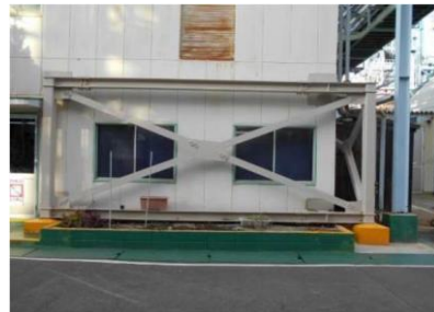
【建屋外の筋交い（ブレース）による補強】
