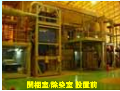
開梱室/除染室 設置前
