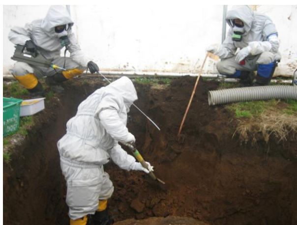
写真1 掘削確認調査実施状況
