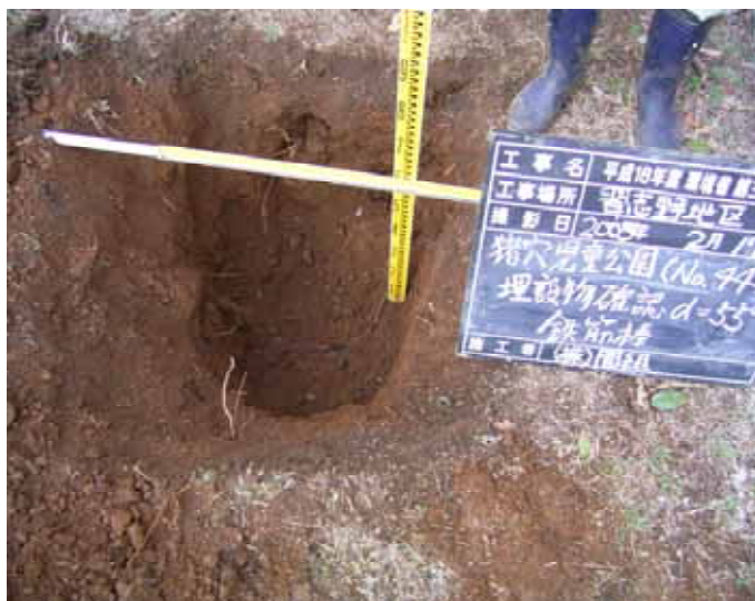
埋設物の例 鉄筋棒 (深さ 55 cm、長さ約 50 cm、重量計 0.9 kg)
