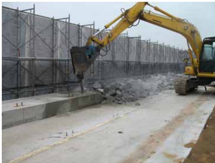
テント基礎解体状況
