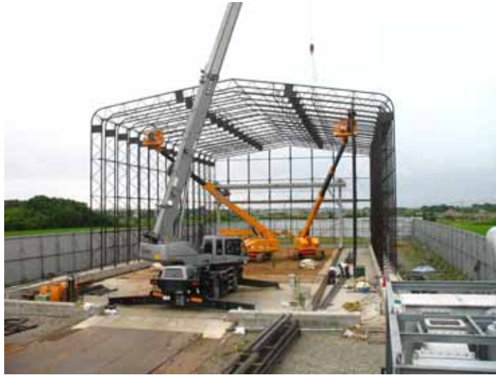
掘削テント上屋解体状況
