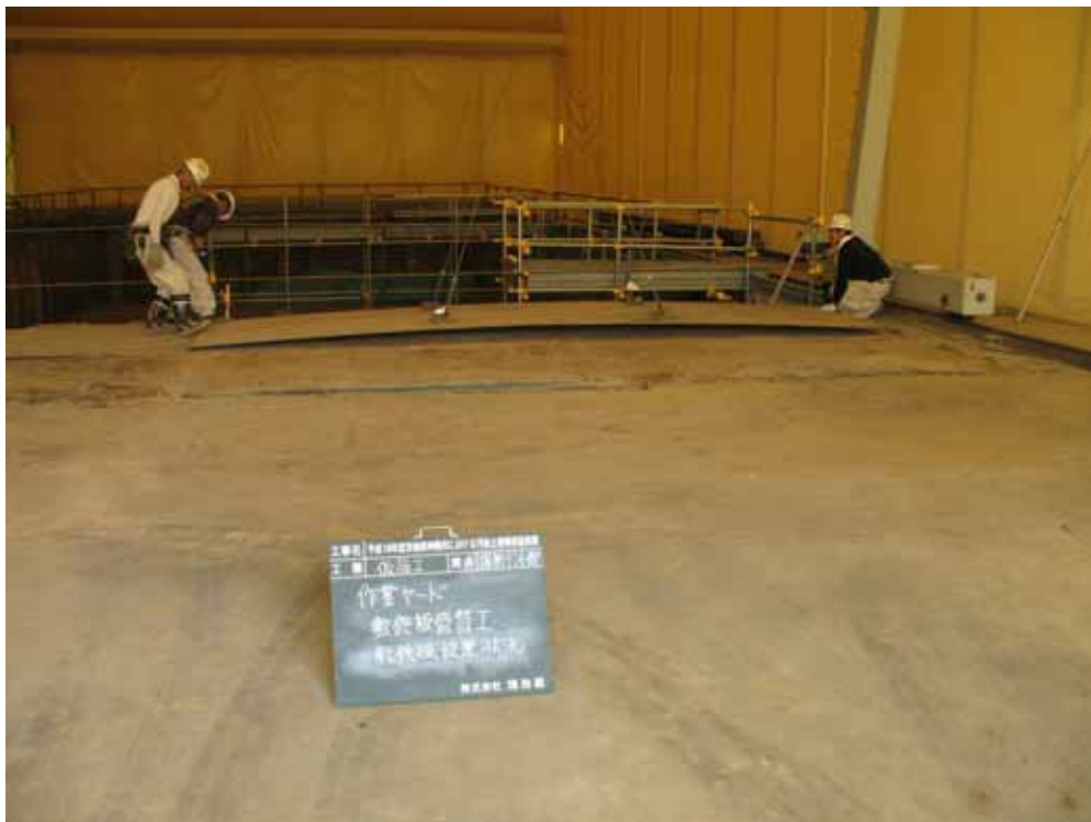
掘削tent内 詰め替え作業場所の整備の様子
