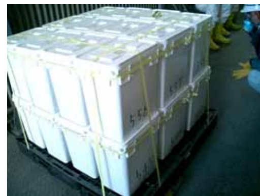
汚染土壌等を詰め込んだ容器姿
