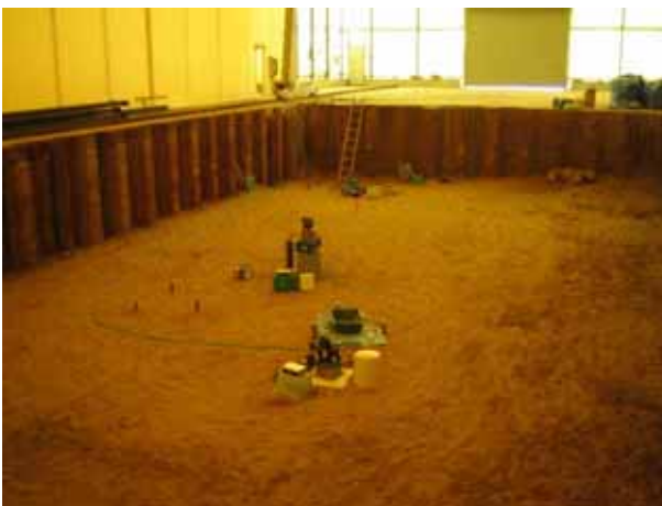
揚水試験井戸設置状況
