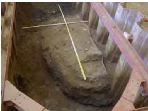
掘削エリア外のコンクリート様の塊
