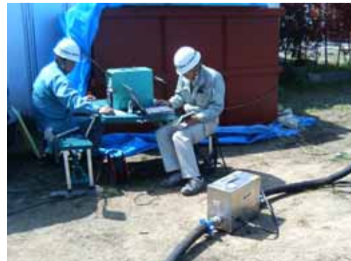
揚水調査の状況(流量測定)
