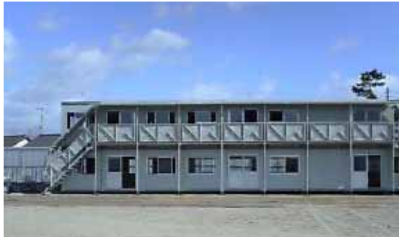
現場事務所の様子(9月22日撮影)
