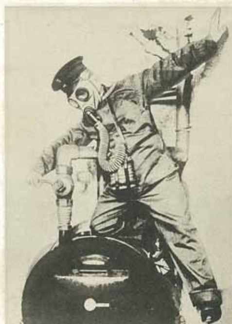
氣密ならざる「パイプ」よりガスの漏洩を 防止する爲職工は一酸化炭素防毒面を裝 着してガス溜の栓を閉鎖す
