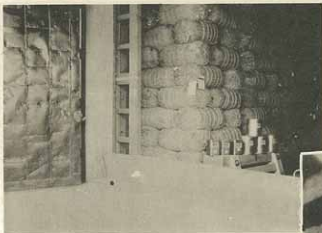
塩化「ピクリン」に依る穀倉の害虫駆除 此際には防毒面を装着して作業す
