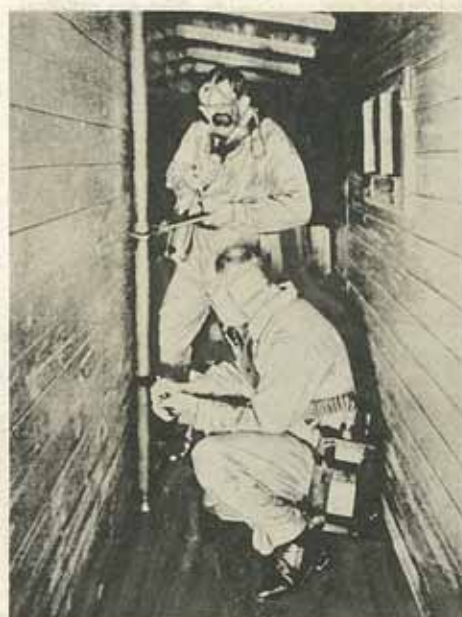
一酸化炭素の存在する室に於て一酸化炭素防 毒面を使用しガス導管を取付くる所（獨逸）
