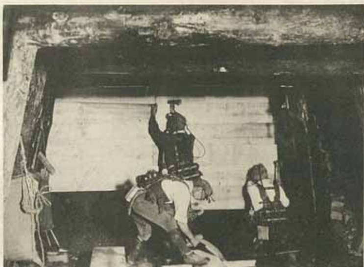
炭鑛爆發に際し「プロト」酸素呼吸器に依り板密閉作業
