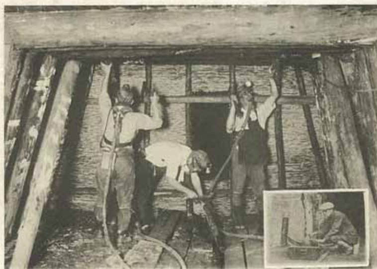
炭鑛爆發に際し通氣管防毒面に依り充填「ダム」造築作業
