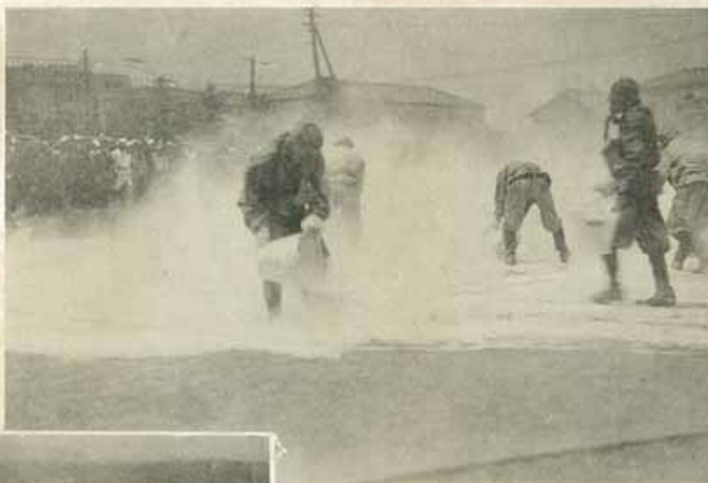
ガス爆撃を受けたる都市に於て爆撃終了と同時に消毒作業を開始せる消毒班の活動
