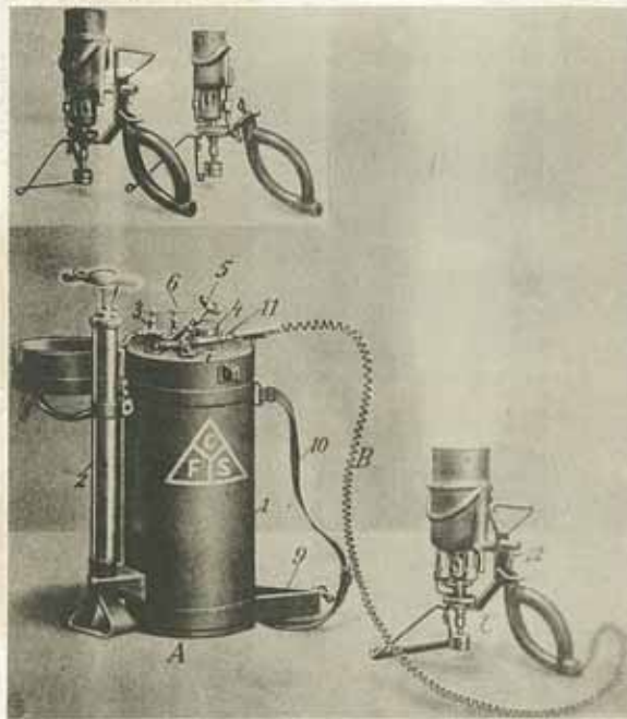
獨逸「シュトルツエンベルグ」社の腐爛性毒物消却燈(本消器は「バーナー」を特種撒毒用噴射口と交換することに依り直に撒毒器をして使用し得るものなりとして佛國側の注目を惹きたるものなり) (Z. S. S. 1931)
